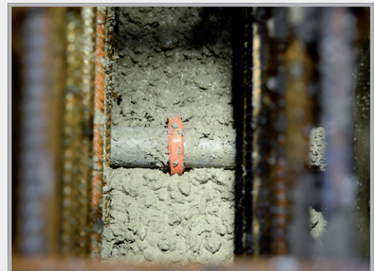
Die Mauerstärke mit ActiveRing wird einbetoniert.
