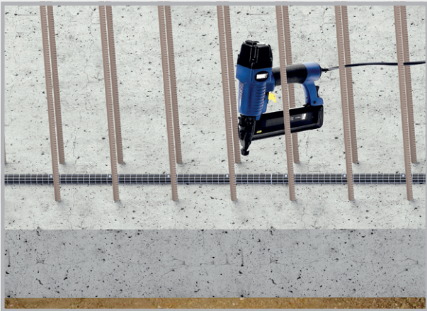
Verlegung mit Befestigungsgitter und Nägeln
