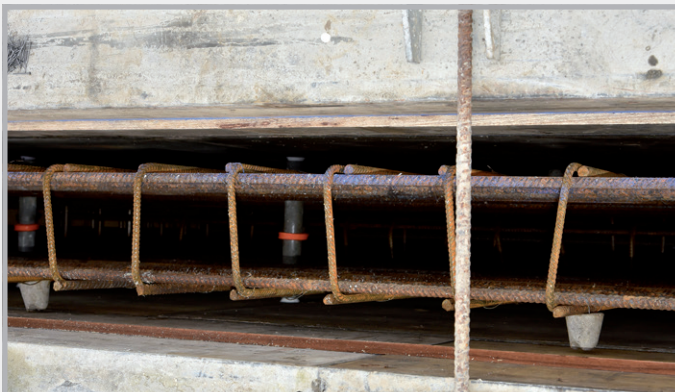
Wandschalung von oben
