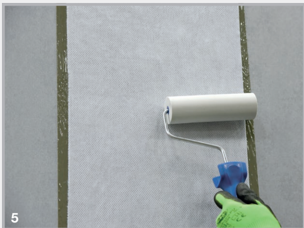
5 Mit der Andrückrolle das Vlies vollflächig in die Beschichtung einrollen. Dieser Arbeitsgang ermöglicht den Auftrag der zweiten Lage, je nach Temperatur und Luftfeuchtigkeit, nach ca. 2 – 3 Stunden.
