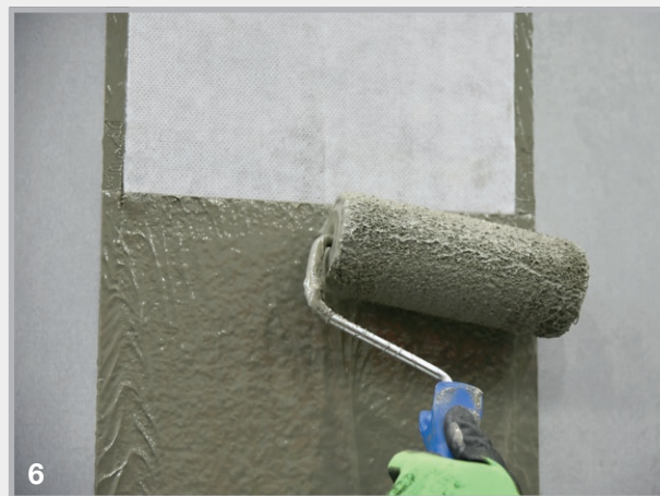
6 Zweite Beschichtungslage auftragen. Schichtstärke ca. 1,2 mm Verbrauch ca. 0,6 kg je Meter/Fuge Der Randbereich des Vlieses muss komplett überdeckt sein.
