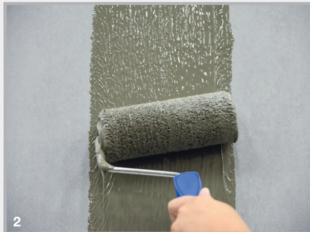
2 Erste Beschichtungslage auftragen. Schichtstärke ca. 1,2 mm Verbrauch ca. 0,6 kg je Meter/Fuge
