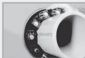
MASTER-SEAL in den Ringspalt einschieben
