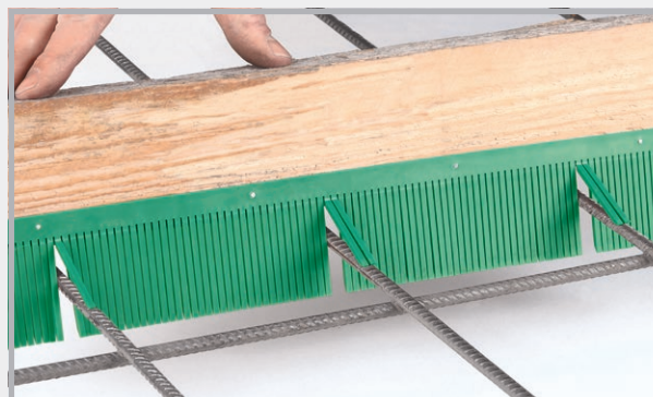
Kantholz positionieren, ausrichten und rückverankern
