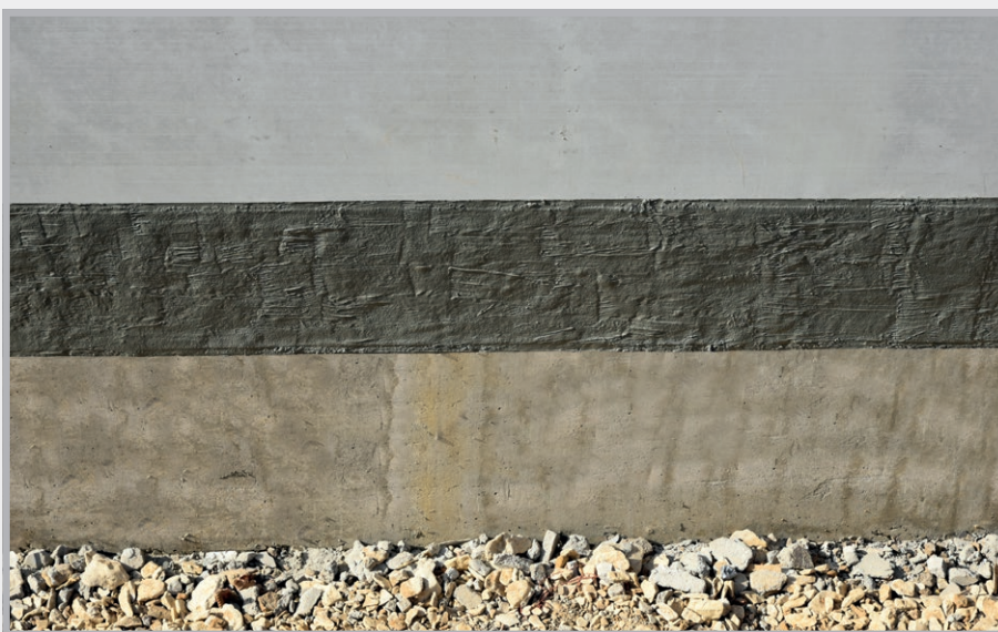
Abgedichtete Lagerungsfuge
