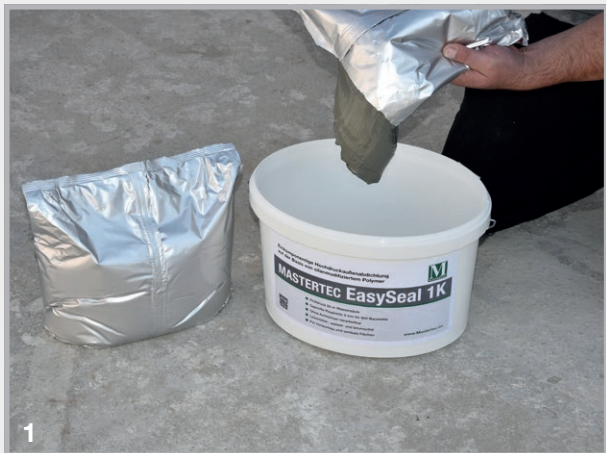
1 Die Beutel öffnen und die Beschichtung in den Eimer geben.
