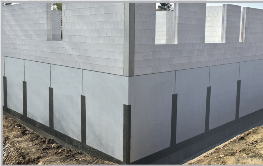
Abgedichtete Lagerungs- und Stoßfugen
