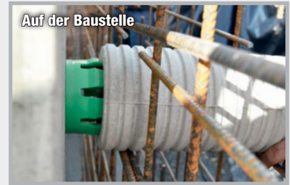
Befestigung ohne Schraub- adapter mit Nägeln. Für eine leichte Entschalbarkeit keine Schrauben verwenden.
