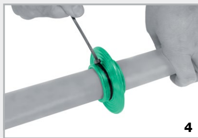
Festes Anziehen der beiden Spannbänder von Hand
