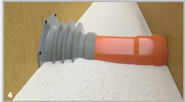
4 Betonage und sorgfältige Verdichtung
