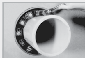
Nacheinander jede Schraube mit einer Umdrehung anziehen und dies im Kreis herum so lange wiederholen, bis alle Module gleichmäßig fest sind
