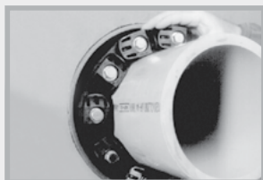
MASTER-SEAL in den Ringspalt einschieben
