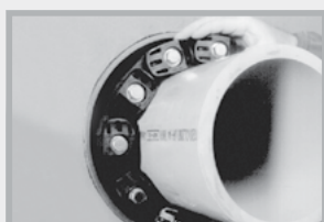
MASTER-SEAL in den Ringspalt einschieben
