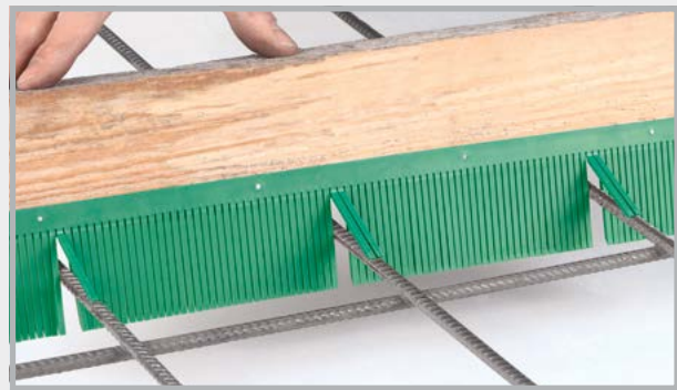
Kanthaloz positionieren, ausrichten und rückverankern
