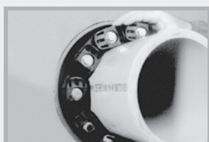
MASTER-SEAL in den Ringspalt einschieben
