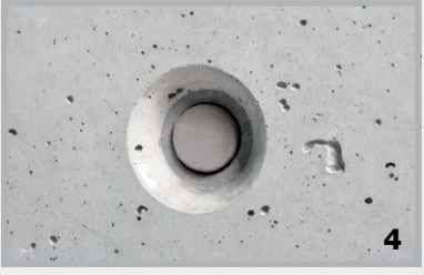
Bündiger Verschluss bei Mauerstärken mit Konus.
