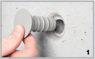
STOPPER maxi in die Mauerstärke eindrücken
