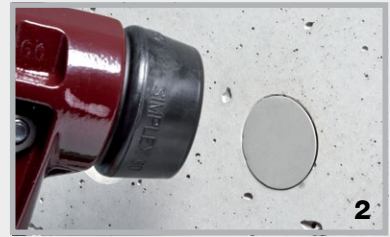
Einschlagen mit dem Gummihammer
