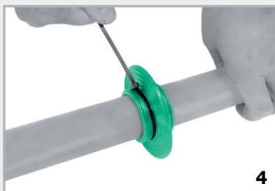
Festes Anziehen der beiden Spannbänder von Hand
