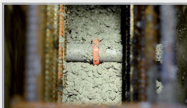
Sur le chantier
