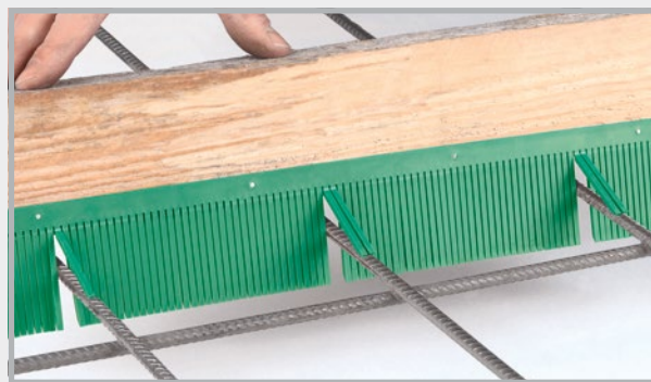
Positionner, aligner et fixer la cale en bois
