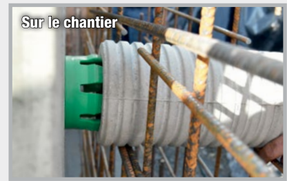
Fixation sans adaptateur à vis avec des clous. Pour faciliter le décoffrage, ne pas utiliser de vis.
