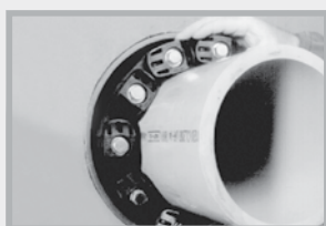
Placer MASTER-SEAL dans l'espace annulaire.
