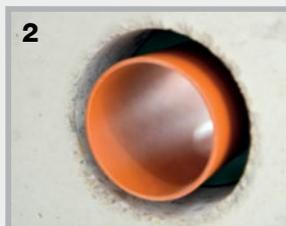
**2.** ...le tuyau de tout-à-l'égout est entièrement enfoncé à travers le joint et le collier de serrage est serré à la main avec une clé polygonale.
