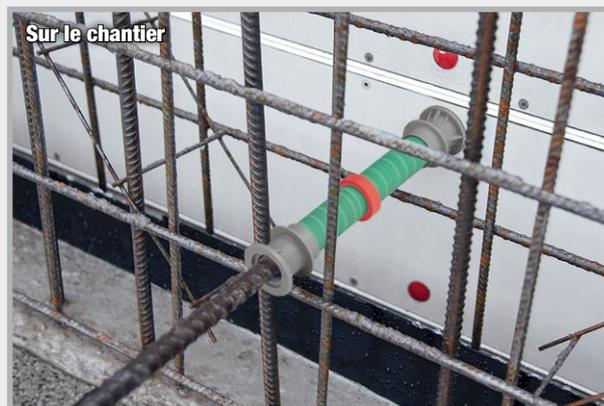
Après le décoffrage, ActiveRing se trouve au centre de l'élément de construction en béton. ActiveRing assure l'étanchéité de la transition entre le tube entretoise STOPPER et le béton de manière sûre et durable.
