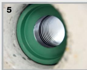
**5.** ...la gaine de protection du câble est ainsi raccordée au carottage ou au tube fourreau de manière étanche à l'eau sous pression.
