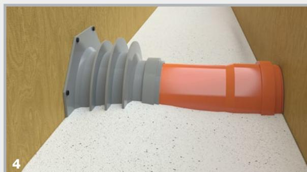
4 Bétonnage et compactage soigneux
