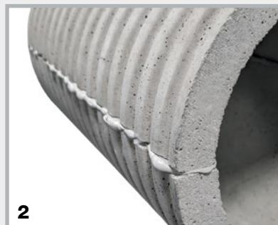
2. Mettre la coque supérieure en place et appuyer dessus de façon à faire ressortir la colle du joint. Ce faisant, veiller à ce que les écarteurs restent en place. Lisser les joints à l'intérieur du tube fourreau pour obtenir une surface propre en vue de l'éventuelle mise en place d'un insert d'étanchéité.
