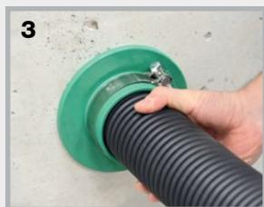
**3.** ...le collier de serrage est placé sur le joint de raccordement et le tube de raccordement est inséré jusqu'en butée...
