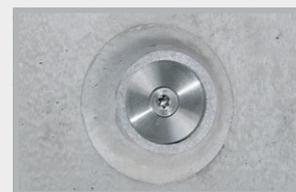
Obturation pour tubes entretoises avec ouverture bague (en haut) ou ouverture conique (en bas).
