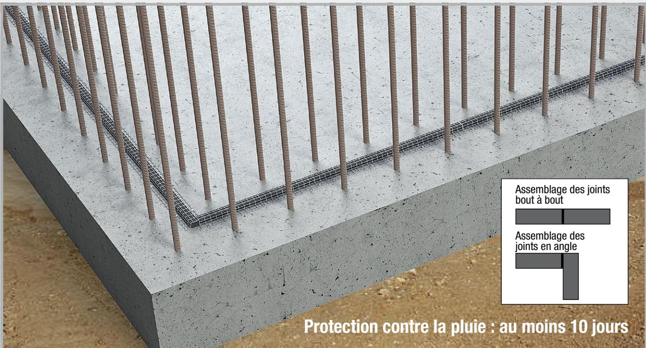
Montage MASTERSTOP LONG TIME avec grille pour joint hydrogonflant
