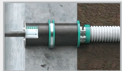
Eingeführte Medienleitung nach der Montage des Dichtungseinsatzes
