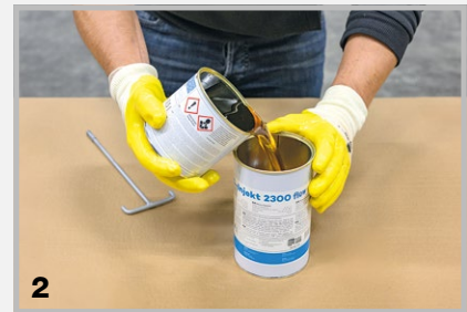
2 Den kompletten Inhalt der Härterkomponente A in die Kombidose der Komponente B füllen.
