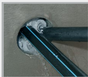
Füllen des Ringspaltes
