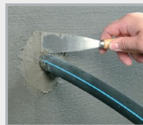
Verspachteln mit Schnellzement
