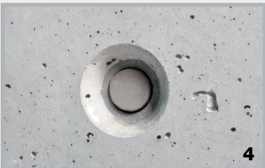
Bündiger Verschluss bei Mauerstärken mit Konus.
