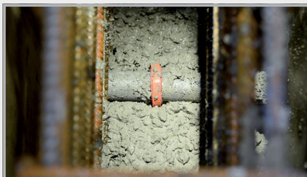
Auf der Baustelle
