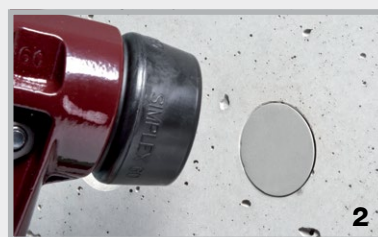
Einschlagen mit dem Gummihammer
