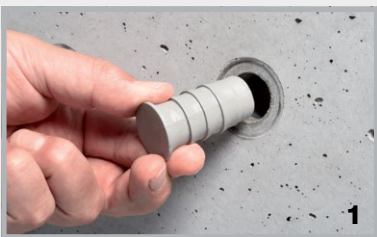
STOPPER mini ansetzen und einschlagen
