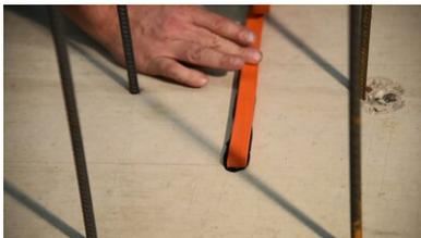
Nach dem Aufbringen des Quellbandklebers „POWER“, in der Mitte der Fuge, wird das **FLOWSTOP Hochdruck-Quellband** auf den Kleber aufgelegt und gleichmäßig angedrückt. Hierzu sollte das **FLOWSTOP Hochdruck-Quellband** leicht hin und her, quer zur Längsachse, bewegt werden. Der Kleber sollte im Endzustand leicht an beiden Seiten herausquellen. Dies garantiert eine vollflächige Fixierung.
