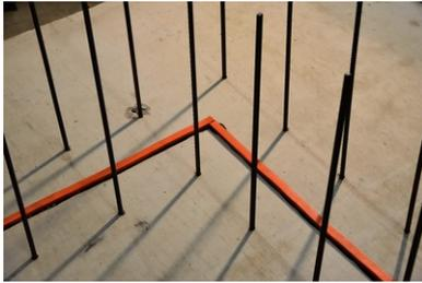
Stöße, egal ob bei Ecken oder in der Geraden werden als Stumpfstoß ausgeführt. Die Stöße müssen formschlüssig sein um Fehlstellen im System zu vermeiden.
