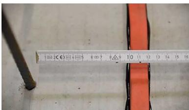
Es ist auf eine Mindestbetondeckung von 8 cm zu achten. Der Einbau muss immer innerhalb einer beidseitigen Anschlussbewehrung erfolgen.
