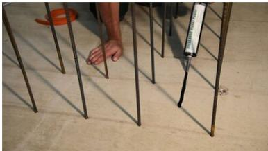
Der Untergrund muss sauber, trocken und frei von losen Teilen sein. Den Kleber aus der Kartusche in einer gleichmäßigen Raupe (Breite ca. 8-10 mm) auf die Betonoberfläche aufbringen.
