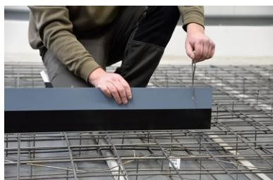
**Dichtblech VB** mittig zur aufgehenden Wand auf die Oberbewehrung aufsetzen.
