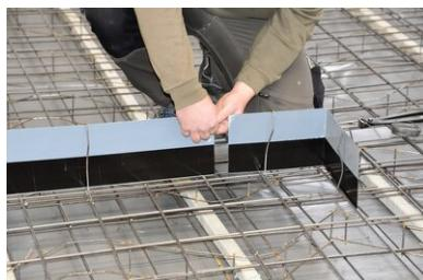
Im Stoßbereich, in der Geraden sowie auch im Eckbereich, muss das **Dichtblech VB** mindestens 6 cm überlappt werden.
