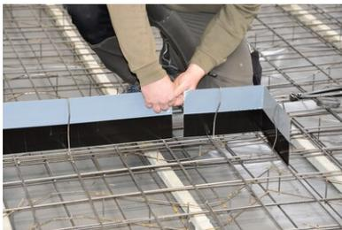
Im Stoßbereich, in der Geraden sowie auch im Eckbereich, muss das **Dichtblech VB JGS** mindestens 6 cm überlappt werden.
