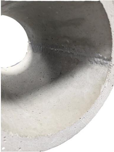
Die Fugen im inneren des Futterrohrs glatt ziehen um eine saubere Fläche für den evtl. Einbau einer Ringraumdichtung o.ä. zu erhalten.
