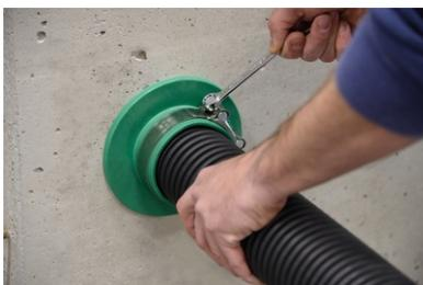
Danach die Spannschelle handfest Anziehen und somit das Wellrohr sichern.
