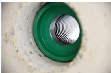
Das Wellrohr ist jetzt druckwasserdicht an die Kernbohrung / das Futterrohr angeschlossen
