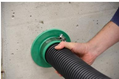
Anschließend die Spannschelle über die Anschlussdichtung legen und das anzuschließende Wellrohr bis zum Anschlag in die Anschlussdichtung einschieben.
