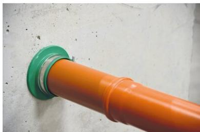
Danach kann das Medienrohr an beiden Seiten an das System angeschlossen werden.
