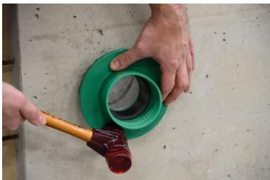
Die **Connector Anschlussdichtung** mit einem Gummi oder Kunststoffhammer gleichmäßig einschlagen, bis die Dichtung bündig an der Bauteiloberfläche anliegt.
