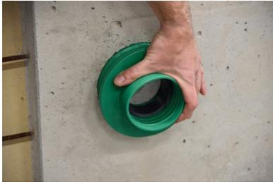
Die **Connector Anschlussdichtung** wird in der Kernbohrung / im Futterrohr positioniert
