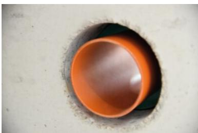
Das KG Rohr wird soweit durch die Dichtung geschoben, wie für den weiteren Anschluss erforderlich.
