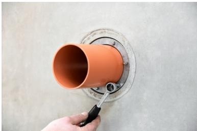
Die Muttern nacheinander mit einem Drehmomentschlüssel per Hand über Kreuz anziehen. Dieser Vorgang muss in mehreren Schritten bis zum Erreichen des vorgegebenen maximalen Drehmomentes wiederholt werden.
