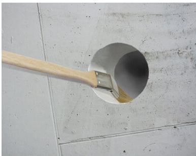
Beim Einbau einer **MASTER-RING Ringraumichtung** in eine Kernbohrung muss die Innenfläche der Kernbohrung vorab mit einem Epoxid-Harz ( PROTECT EP-Harz) konserviert werden.
