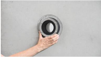
Die **MASTER-RING Ringraumichtung** in das Futterrohr bzw. die konservierte Kernbohrung einsetzen und das Medienrohr durchführen.
