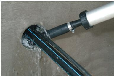
Den flexiblen Aufsatz in die Durchführung einführen und vom Sicherungsblock beginnend die Durchführung mit **FLEX 2000** schließen.
