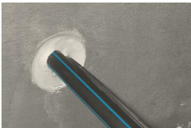
Die **FLEX 2000** - Dichtungsmasse mit einer Spachtel ca. 1 cm vertieft vollflächig verspachteln.
