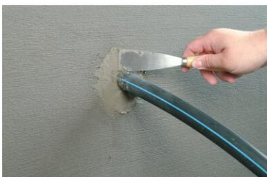
Als äußeren Abschluss eine Plombe aus Schnellzement aufbringen und flächenbündig abspachteln.
