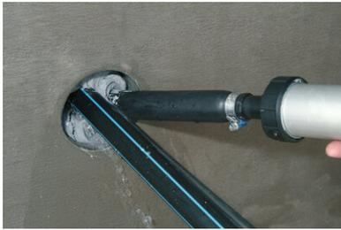
Die Durchführung spiralförmig langsam von innen nach außen mit **FLEX 2000** füllen.
