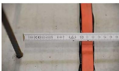
Un revêtement en béton d'au moins 8 cm et un montage à l'intérieur de l'armature sont absolument indispensables.
