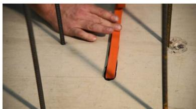
Après l'application de la colle pour joint gonflant „POWER“ au centre du joint, poser le joint sur la colle et l'enfoncer en exerçant une légère pression. Dans son état final la colle devrait affleurer légèrement sur les deux côtés. Cela garantit une fixation sur l'intégralité de la surface.
