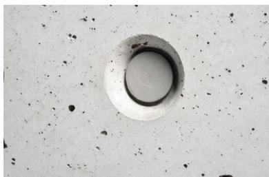
Le **STOPPER mini 22** doit être enfoncé jusqu'à ce que La petite collerette circulaire repose sur la surface intérieure de béton.
