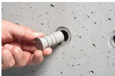
Que ce soit avec des cônes ou des lèvres d'étanchéité, le **STOPPER mini 22** peut être utilisé comme raccord extérieur du tube distanceur.
