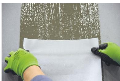
Placer le **voile non tissé Mastertec EasySeal 1K** coupé à l'avance à la longueur souhaitée sur la première couche de **Mastertec EasySeal 1K** et presser légèrement.
