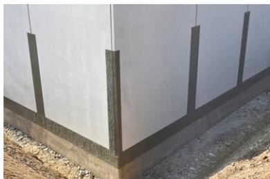
Étanchéité finie avec **Mastertec EasySeal 1K**.
