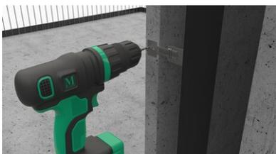
Le coffrage mural est percé pour la fixation de l'onglet de retenue.
