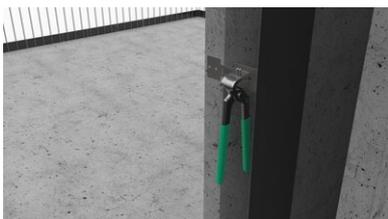
Les onglets de retenue réglables sont ajustés pour la fixation côté parement du coffrage mural.
