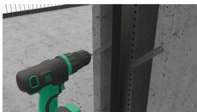
Le coffrage mural est percé pour la fixation de l'onglet de retenue.
