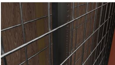
Dans le cas de parois en béton coulé sur place le **profilé de joint de retrait SRF** est fixé sur l'armature par le biais du rail de retenue perforé.
