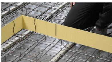
Le joint à recouvrement doit être affermi à l'aide d'une goupille de sécurité jointe à la livraison.
