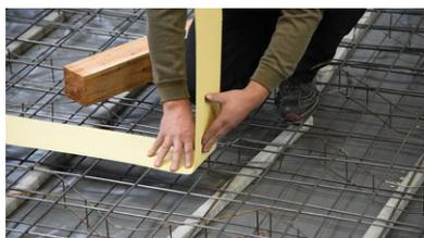
Après un léger alignement l'angle peut être monté sur l'armature.
