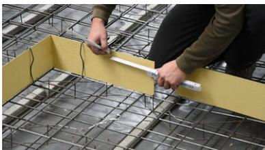
Dans la zone de jointure l'élément de **tôle d'étanchéité MB Overlap** est planté sans collage.
