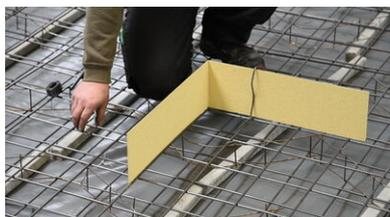
Pour faciliter le montage des éléments de **tôle d'étanchéité MB Overlap** sur l'armature, débiter le montage dans un angle.
