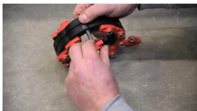
Engager la vis dans les trous existant dans les deux extrémités du caoutchouc et fixer ainsi le joint modulaire clos.
