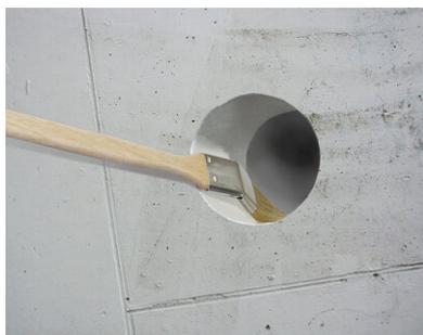
En cas de pose d'un insert d'étanchéité **MASTER-RING** dans un carottage il faut auparavant appliquer un traitement conservateur sur la surface intérieure du carottage avec de la résine époxy (PROTECT résine EP). Ce traitement conservateur sert d'une part à créer une surface libre de pores et d'autre part à empêcher la corrosion sur les aciers d'armature qui ont été sectionnés.
